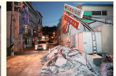
• 흥해읍 상가 외벽 붕괴
