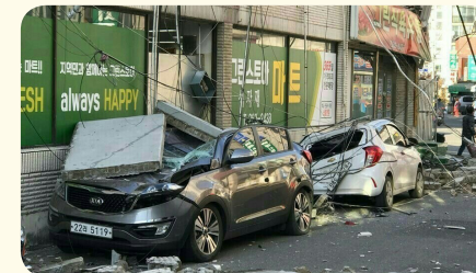
낙하물 차량 파손
